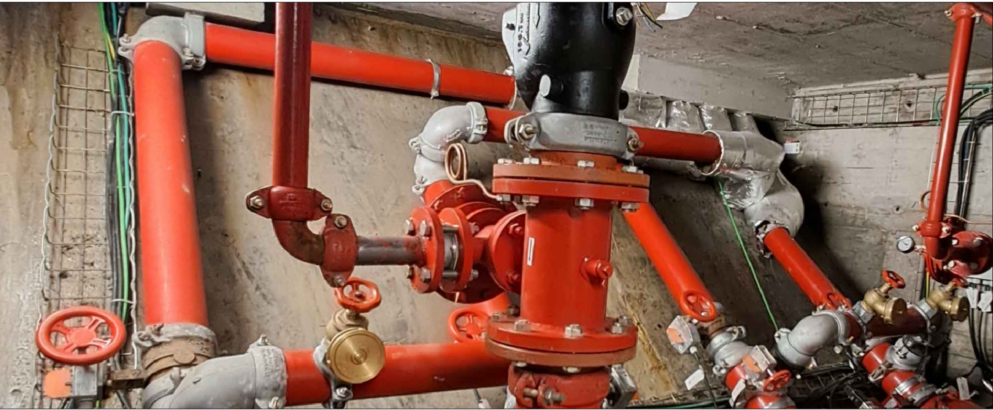
DETTAGLIO VALVOLA DI RITEGNO A MOLLA TIPO WAFER VIR SERIE 775
